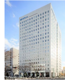
仙台MTビル
