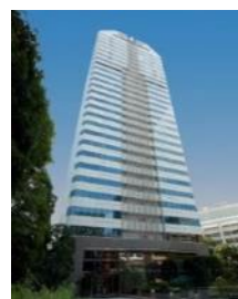
紀尾井町ビル
