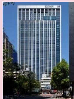
神谷町トラストタワー
