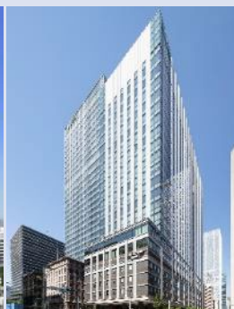
京橋トラストタワー
