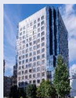
大崎MTビル
