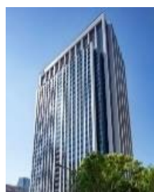
神谷町トラストタワー
