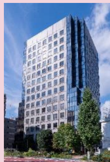
大崎MTビル
