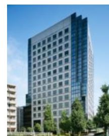
大崎MTビル
