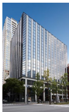
7 御堂筋MTRビル
