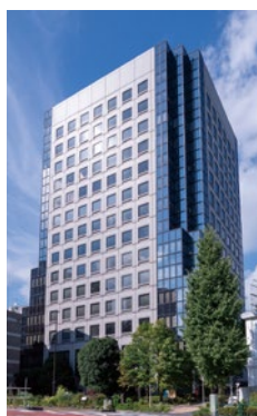
6 大崎MTビル
